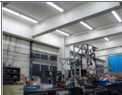
工事完了後のリサイクルセンター 細かい手作業の作業環境向上に期待
